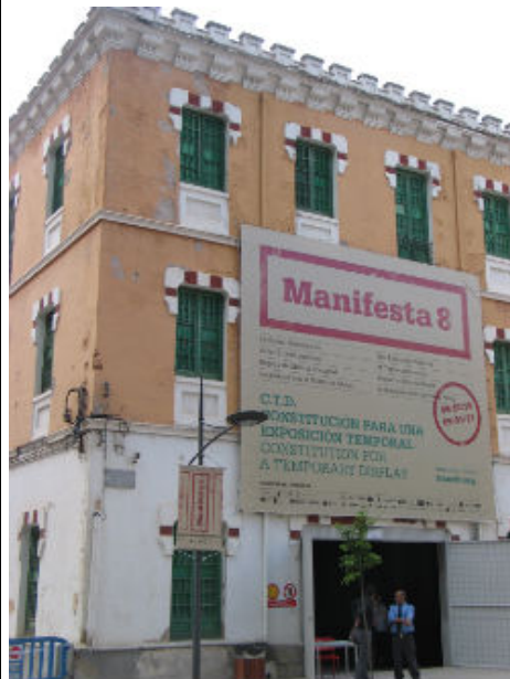
Voormalige barakken in Murcia.
